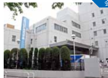
三菱電機ビルテクノサービス株式会社 東京支社
